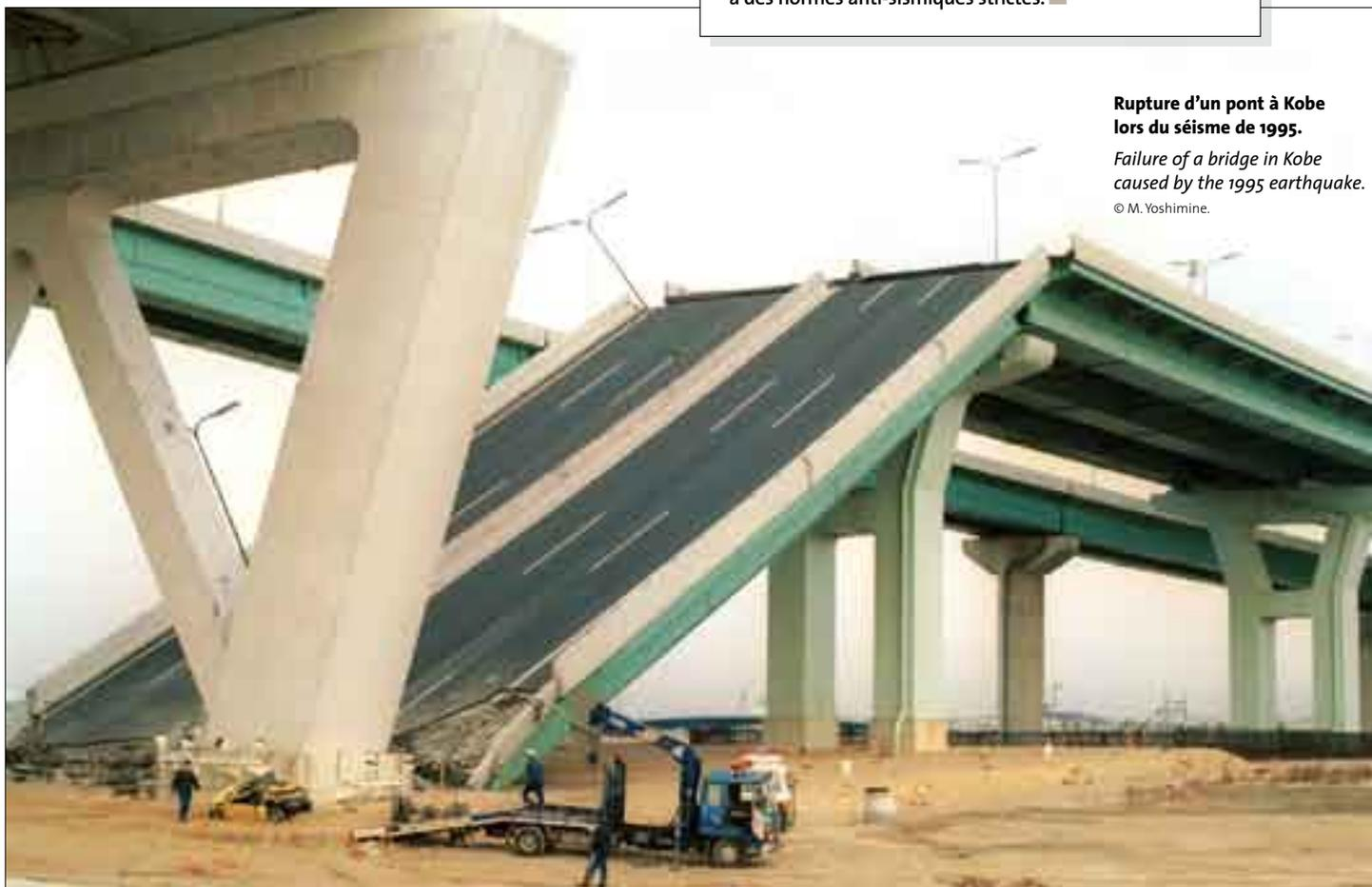
**Rupture d'un pont à Kobe lors du séisme de 1995.**
