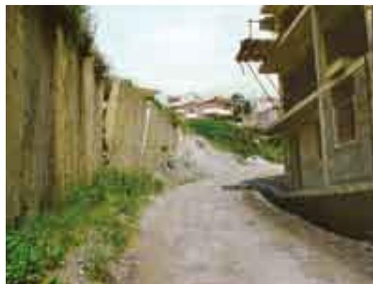
**Photo 4 : Immeuble en construction menacé par l'effondrement du mur amont, sous la pression des galets quaternaires, Contrada Pace, à l'est de Messine.**
