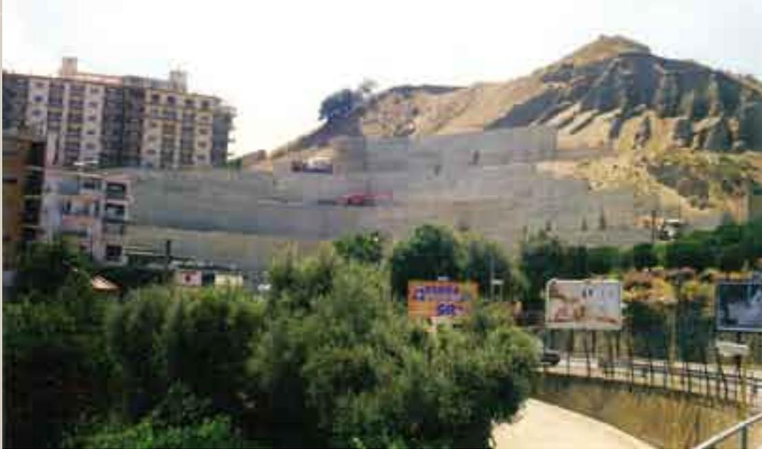
**Photo 2 : La formation de galets quaternaires du Faro et des travaux de protection pour un nouvel immeuble. Au fond, colline de 120 mètres taillée dans les galets du Quaternaire moyen et récent, inclinés vers la gauche (le sud). Ravinements, éboulements et glissements, tablier d'éboulis à la base. À gauche, immeubles en construction. Au milieu, travaux de soutènement pour limiter le glissement des galets.**
