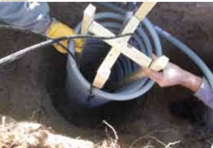
**Photo 1 : Mise en place d'une corbeille géothermique (jusqu'à 10 m de profondeur), plate-forme BRGM, Orléans.**
